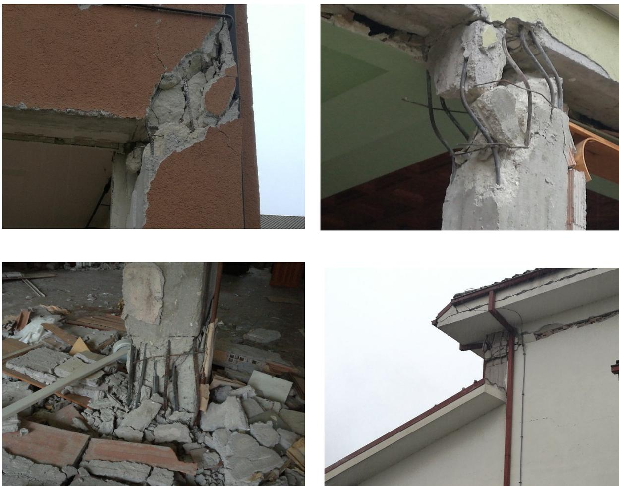
**Figura 5** – Nodi non confinati dalla staffatura nel nodo: (a) – (b) crisi del nodo per mancato confinamento mediante staffatura; (c) Crushing del piede del pilastro terra; (d) Schiacciamento dato dalla copertura pesante ed espulsione del nodo trave pilastro.
