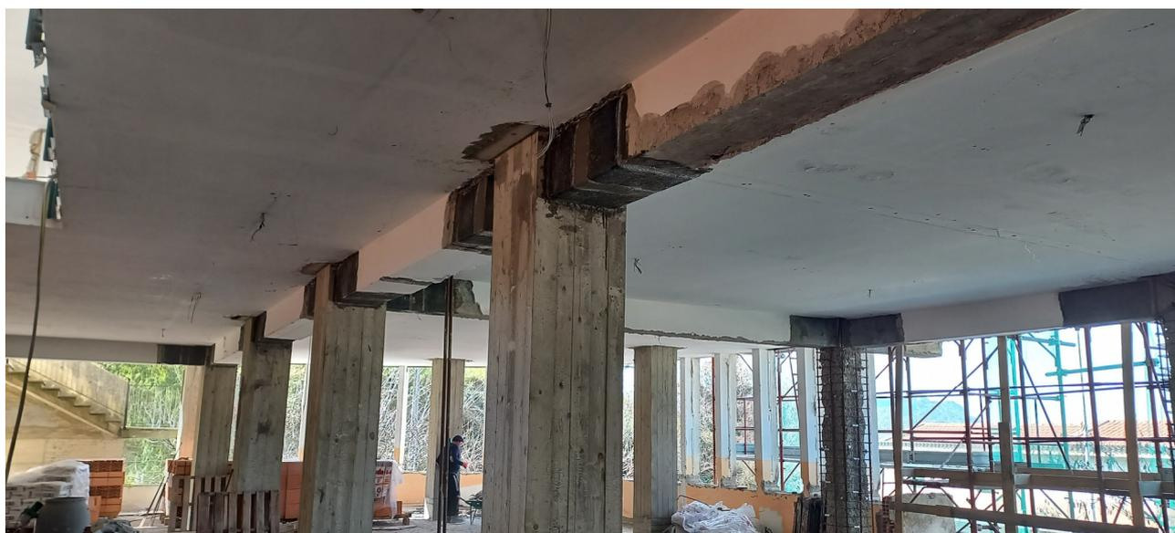
**Figura 1** – Dettaglio di incamicatura in c.a. pilastri e fasciatura a taglio con frp delle travi
