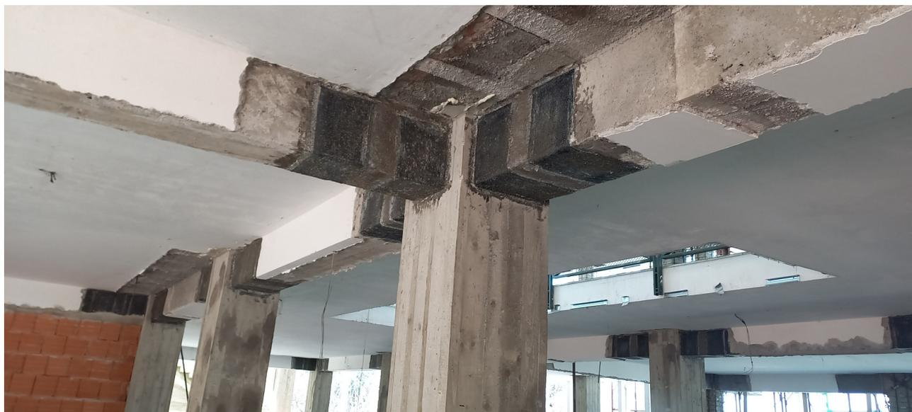
**Figura 2** – Esempio di strip-out e successivo intervento di rinforzo di travi e pilastri.
