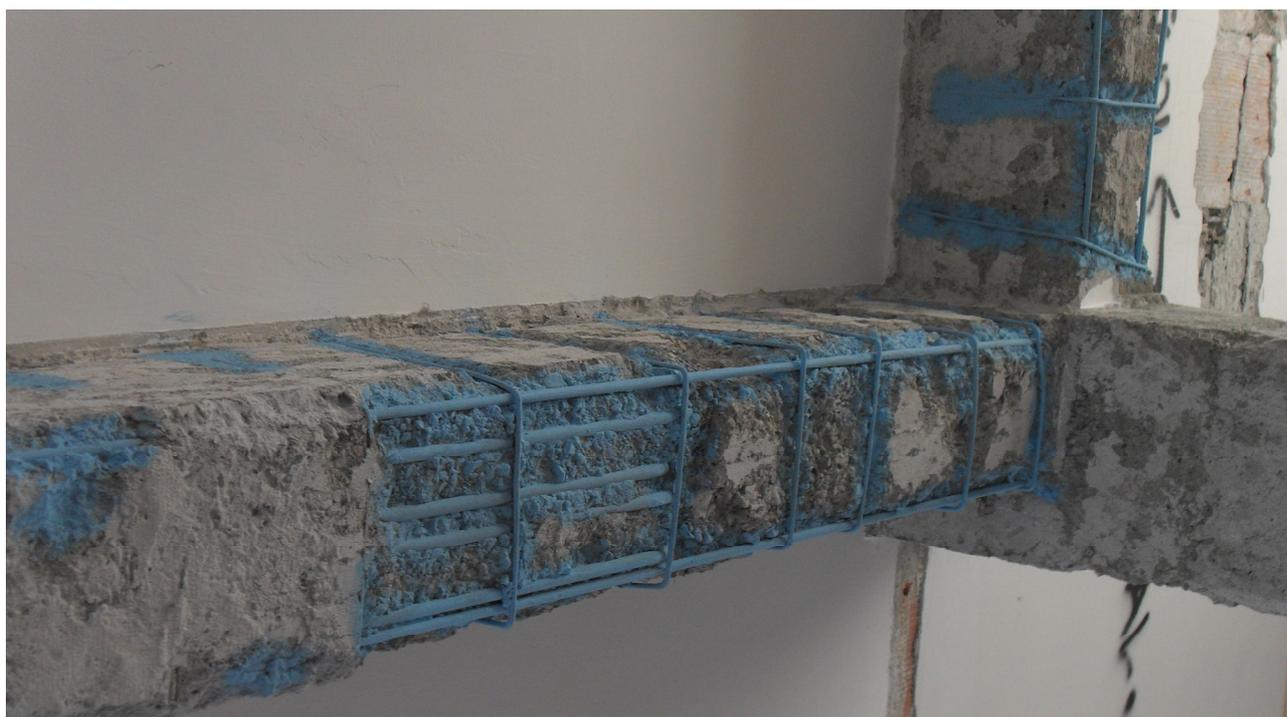
**Figura 3** – *Disposizione non conforme alla buona regola delle armature longitudinali e delle staffe.*
