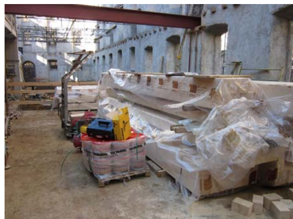
Connettori Tecnaria e travi lamellari stoccate
