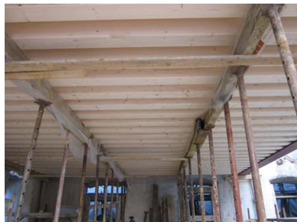
Puntellazione dei solai da sotto
