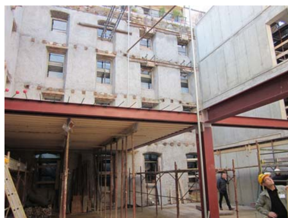
Primi solai realizzati
