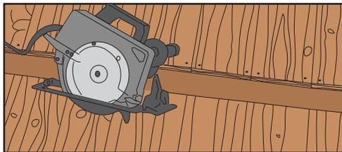
2 Scier le platelage le long des poutres de façon continue à l'aide d'une scie circulaire.
