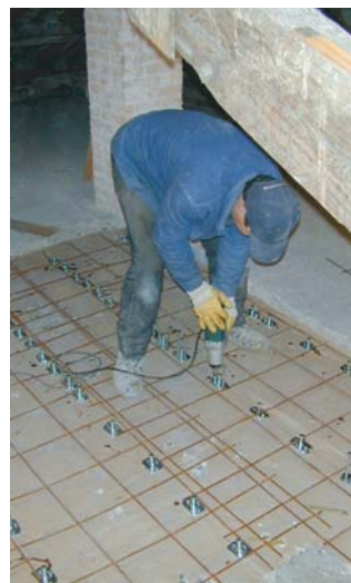
Fissaggio delle viti dei connettori tramite avvitatore elettrico ad impulsivi, con inserto esagonale da 13 mm.
