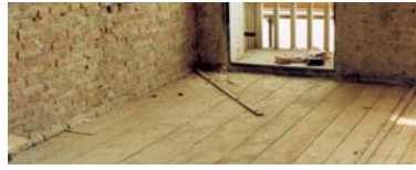
Vista di un solaio dopo la rimozione del sottofondo e della pavimentazione esistenti prima della esecuzione del rinforzo. Sulla destra vista del complesso da Campo Manin.
