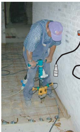
Preforatura dell'assito e della trave tramite doppio trapano. L'attrezzo può anche essere noleggiato
