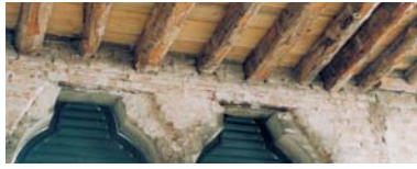
Vista dal basso di un solaio da rinforzare. Il buono stato di conservazione delle travi ne ha reso possibile l'adeguamento statico con questa tecnica.
