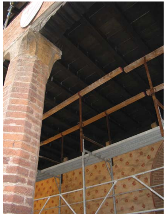
I solai vanno sempre puntellati prima dell'esecuzione del getto per garantire una corretta esecuzione dell'opera.
