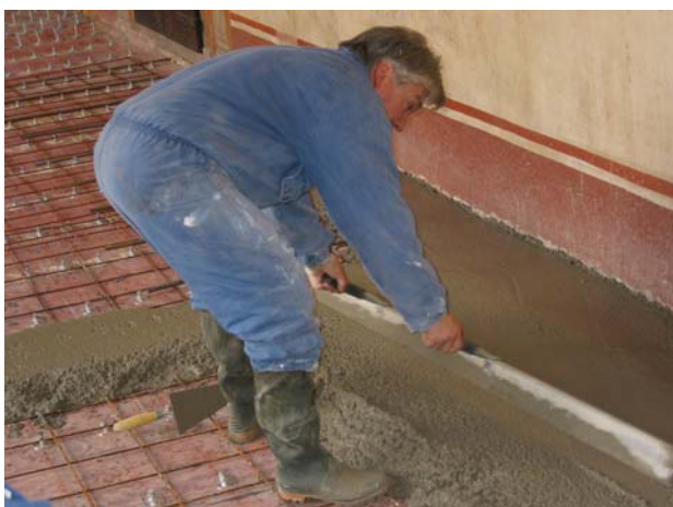
Nella sequenza fotografica sono visibili le fasi di esecuzione del getto e del livellamento del calcestruzzo gettato sul solaio; sono state rispettate le quote originarie. In evidenza un particolare del collegamento della soletta con le murature in corrispondenza di una porta.
