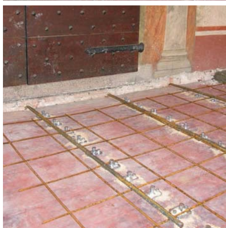
Nella sequenza fotografica sono visibili le fasi di esecuzione del getto e del livellamento del calcestruzzo gettato sul solaio; sono state rispettate le quote originarie. In evidenza un particolare del collegamento della soletta con le murature in corrispondenza di una porta.
