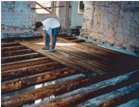
Dopo la posa delle nuove travi lignee negli alloggiamenti già esistenti è stato steso e chiodato l'assito soprastante.
