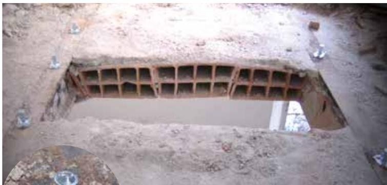
A composição química das vigas de ferro existentes, dificultada pela presença de poeira, ferrugem ou argamassa dificulta ou até impossibilita qualquer tentativa de soldar os elementos. A ligação com os ligadores TECNARIA é a solução mais eficaz, já que pregos penetram diretamente no aço. A simplicidade de instalação faz desse o sistema ideal.
