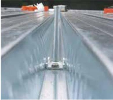
O ligador consiste em um perno, inserido numa placa base na qual dois pregos são inseridos para fixação. O tamanho limitado faz com que seu principal uso seja pavimentos não sujeitos a altas cargas e trabalhos de restauração em geral onde é necessária grande flexibilidade de uso.
