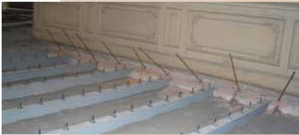
A partir da segunda metade do século dezanove, pavimentos eram frequentemente feitos usando vigas "duplas em formato T" com arcos de tijolos, como uma alternativa a pavimentos de madeira. As vigas se apoiavam nas paredes principais com um espaçamento normalmente variando de 60 a 110cm. O espaço entre as vigas era preenchido com elementos de tijolos sólidos ou ocós.
