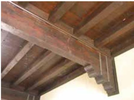
Pavimento com vigamento duplo visto de baixo: as vigas principais podem ser vistas com as vigas secundárias colocadas transversalmente.
