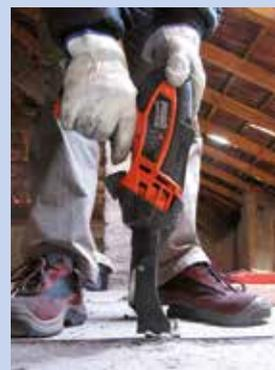
Um dos principais méritos do sistema é a fixação rápida e segura, feita com uma arma de pregos, que está disponível para contratação. Entretanto, fixar o prego à viga pode criar vibrações e isto deve ser considerado se há elementos que podem ser danificados (por exemplo tetos de gesso). Caso esses ligadores sejam soldados.
