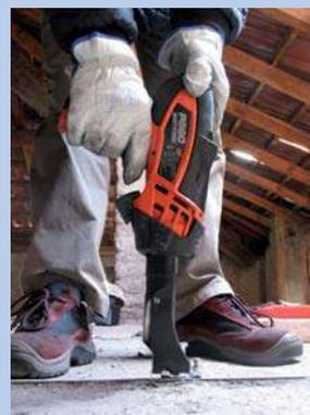
Uno dei pregi principali del sistema è il fissaggio rapido e sicuro eseguito con una chiodatrice a sparo fornita anche a noleggio. L'infissione del chiodo nella trave può generare delle vibrazioni dato di cui occorre tenere conto se vi sono elementi daneggiabili (ad es. soffitti in gesso). In casi rari si ricorre alla saldatura dei connettori.
