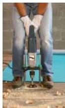
Taladro de par elevado montado en un soporte estable; permite hacer grandes orificios en el entarimado para alojar los conectores "BASE" con total seguridad para el operador.
