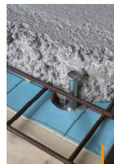
Con una fresa de punta realizar orificios de  $\varnothing$  65 mm en el piso para el conector **BASE**. Esa aplicación no se aconseja en caso de pisos de madera dura y de pisos ya existentes fijados con muchos clavos.
