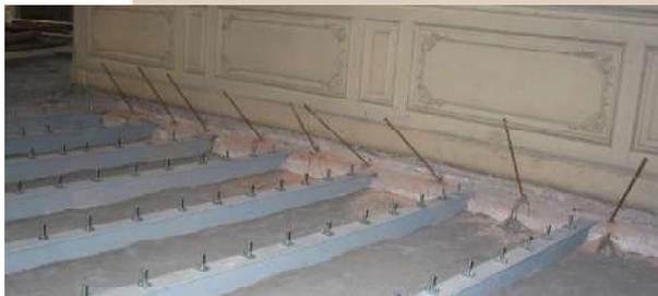
Como alternativa a los forjados de madera, a partir de la segunda mitad del siglo XIX, se realizaban a menudo forjados con vigas de hierro de doble "T" con elementos de ladrillo intercalados. Las viguetas se apoyaban en los muros portantes con distancias entre ejes variables normalmente de 60 a 110 cm y se distanciaban con elementos de ladrillo macizo o perforado.
