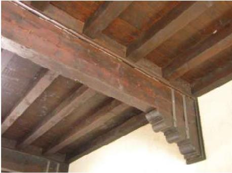
Forjado de doble entrevigado visto desde abajo: se ven las vigas principales y las viguetas secundarias con entrevigado transversal.
