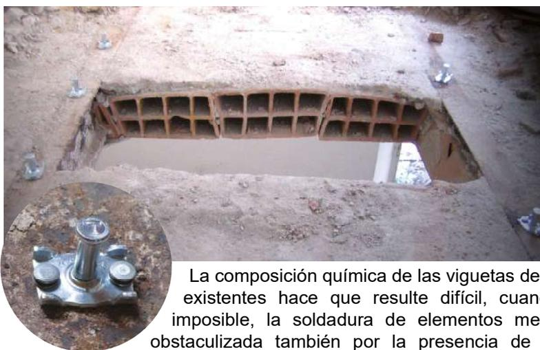
La composición química de las viguetas de hierro existentes hace que resulte difícil, cuando no imposible, la soldadura de elementos metálicos obstaculizada también por la presencia de polvo, oxidaciones o mortero: la fijación en frío con conectores TECNARIA resuelve de forma eficaz el problema ya que los clavos penetran directamente en el acero. ¡La simplicidad de colocación en la obra hace que el sistema sea ideal para este uso!
