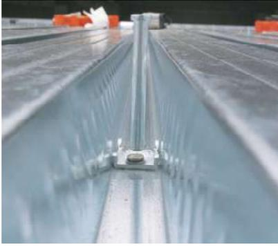
El conector está formado por un perno con cabeza introducido en una placa de base en la que se fijan **dos clavos**. Dado su tamaño la utilización principal es para forjados sin esfuerzos relevantes, para rehabilitaciones y en general donde se requiere una gran flexibilidad de uso.
