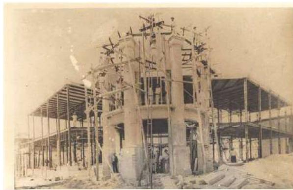
Según los manuales técnicos de la época los esfuerzos de las vigas tenían que variar de un mínimo de 900 kg/cm<sup>2</sup> a un máximo de 1.600 kg/cm<sup>2</sup>.
