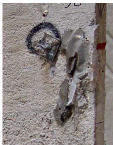
Fig. 6: Adesione del getto della soletta al travetto.
