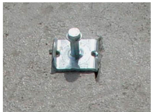
Fig. 3. Connettore inserito nel travetto
