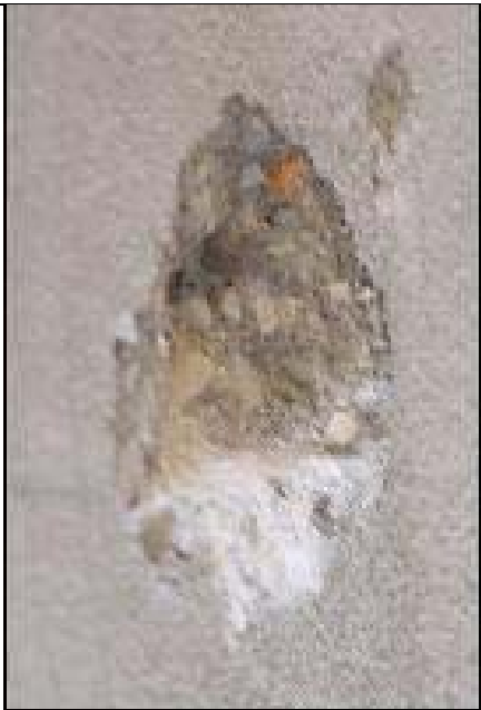
Fig. 11. Zona di calcestruzzo danneggiata attorno al gambo filettato del connettore (lato travetto)
