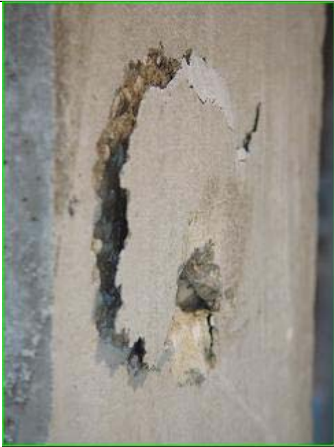
Fig. 11. Zona di calcestruzzo danneggiata attorno al gambo filettato del connettore (lato travetto)
