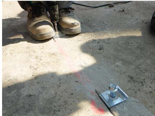
Serraggio della vite
