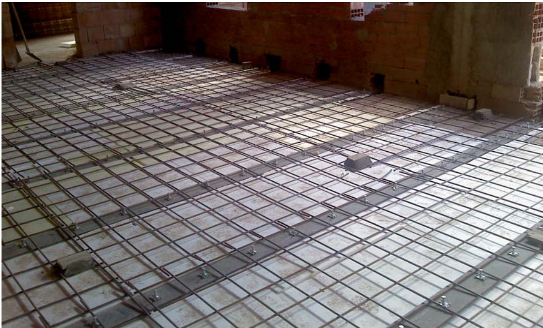
Successivamente si è proceduto ad interporre un sottile pannello di isolante (1 cm) e rete elettrosaldata
