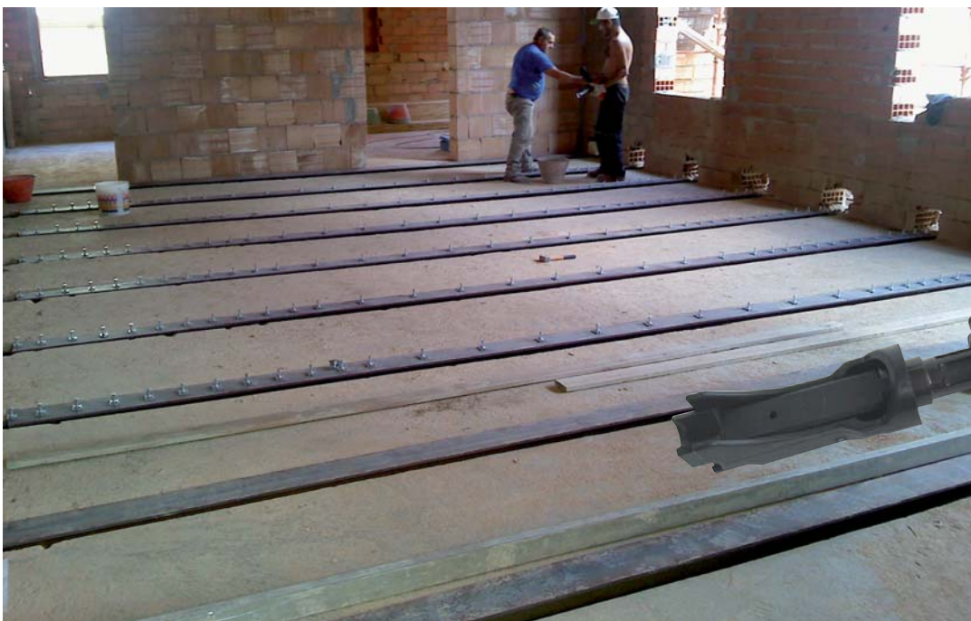
Le travi vengono connesse con i connettori CTF infissi con chiodatrice a sparo: più fissi agli appoggi e più diradati in mezzzeria
