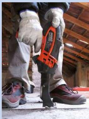
Una de las principales cualidades del sistema es la fijación rápida y segura realizada con una clavadora de disparo que también puede alquilarse. La introducción del clavo en la viga puede generar vibraciones, un dato que hay que tener en cuenta si hay elementos que puedan dañarse (por ej. techos de yeso). En casos raros se recurre al soldado de los conectores.
