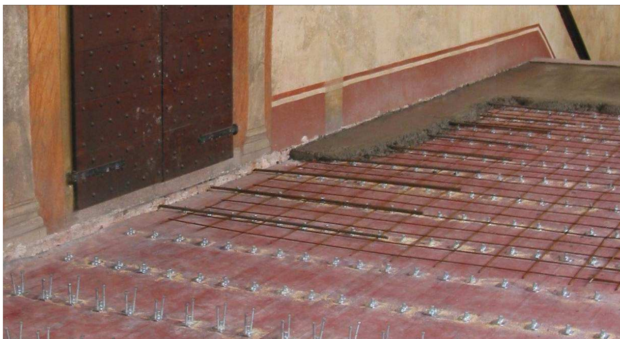
Figura 1 Solaio in legno rinforzato con soletta in calcestruzzo, rete elettrosaldata e connettori Tecnaria; sono presenti le barre di collegamento ancorate alla muratura.
