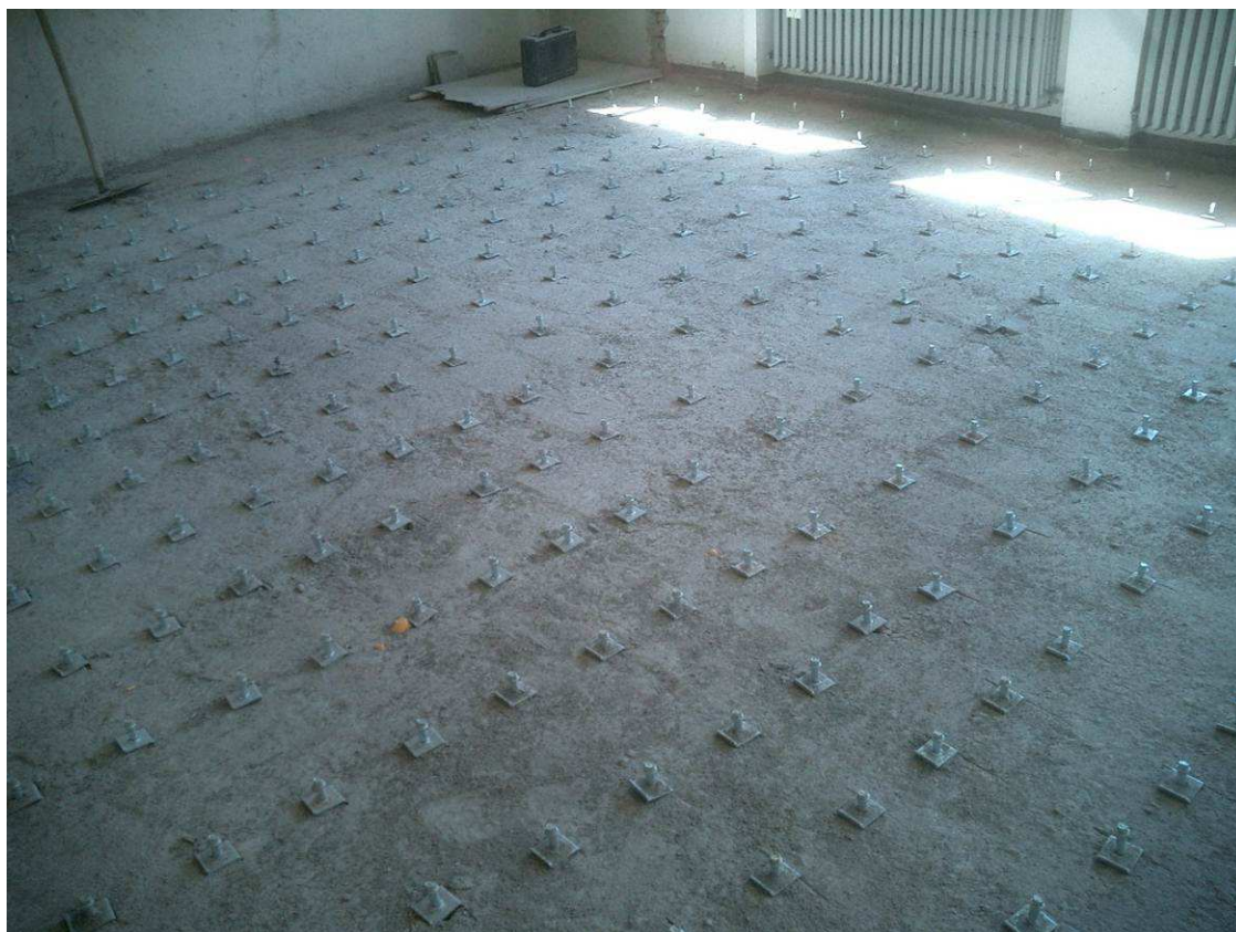
Figura 5 Solaio tipo Bausta con sottofondo e pavimento rimossi e disposizione dei connettori . Seguirà posa di rete e getto di calcestruzzo.
