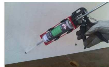
Installazione con pistola manuale
