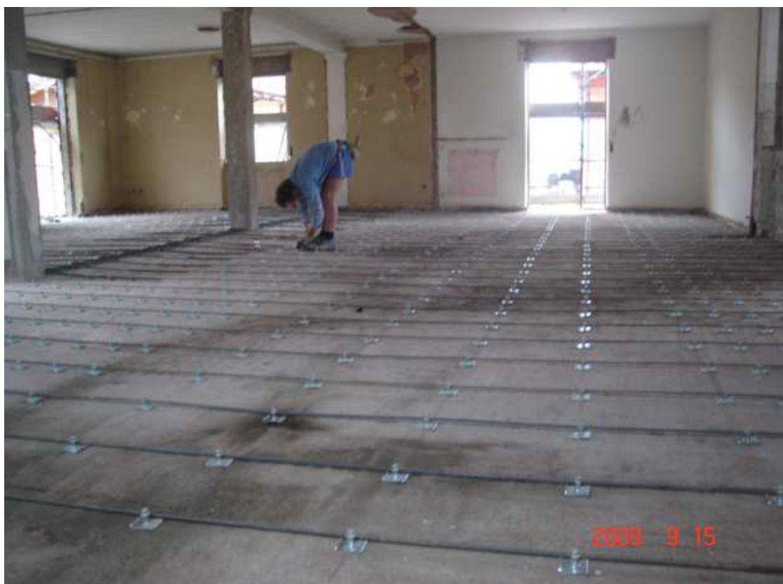
Figura 5 Solaio tipo Bausta con sottofondo e pavimento rimossi e disposizione dei connettori . Seguirà posa di rete e getto di calcestruzzo.
